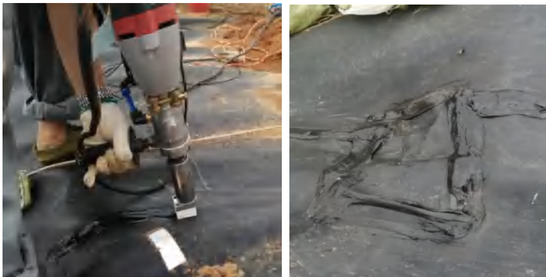
沼气池修补照片
