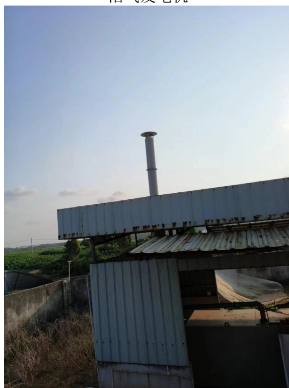
无害化处理设施排气筒
