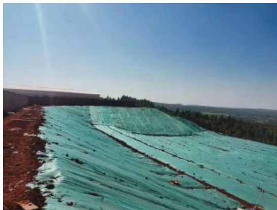
照片 9 裸露边坡苫盖 2
