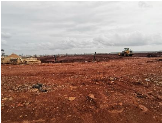
照片 7 项目区前期施工平整 2
