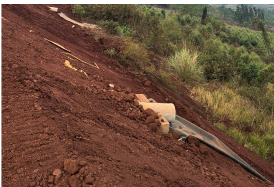
照片 11 项目区外排水沟出口 1
