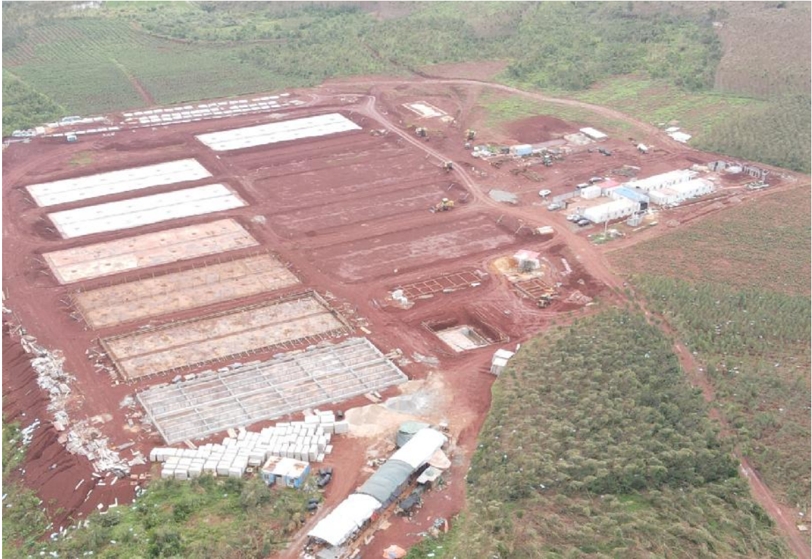
照片 14 施工中航拍
