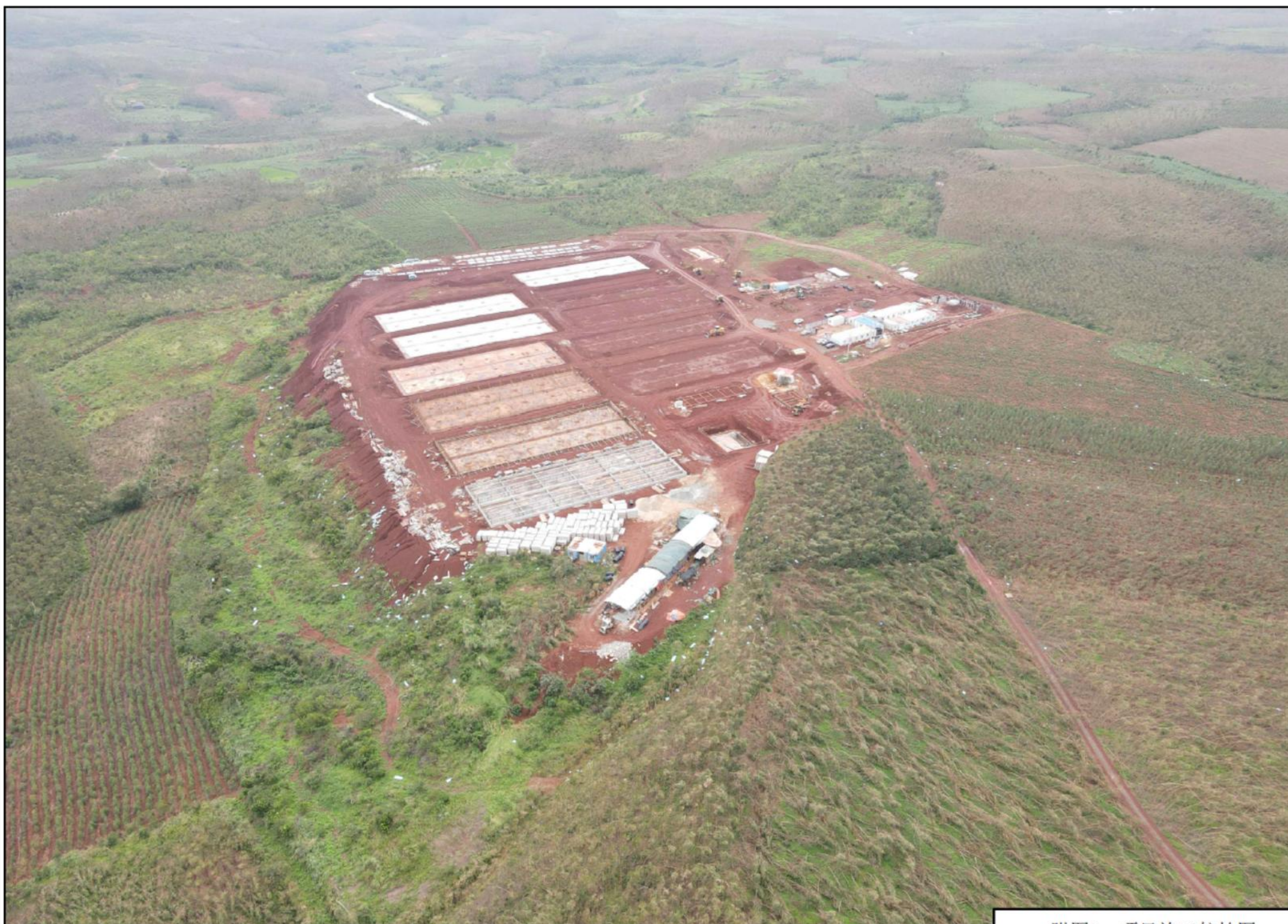
附图3：项目施工航拍图
